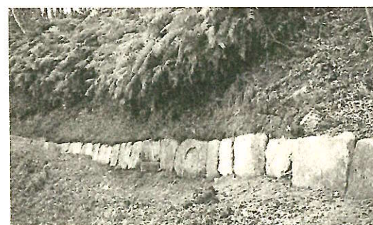
土塁の基礎補強に並べられた石
